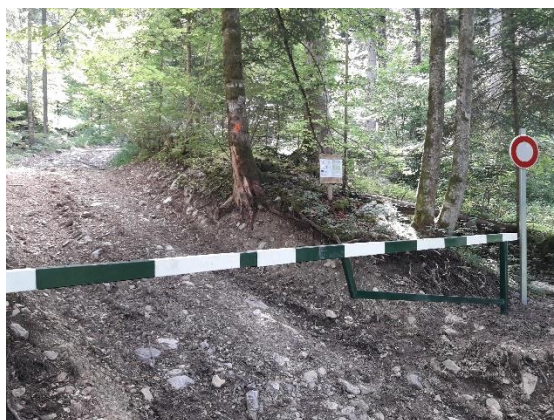
Départ de la piste forestière – pose d'une nouvelle barrière
