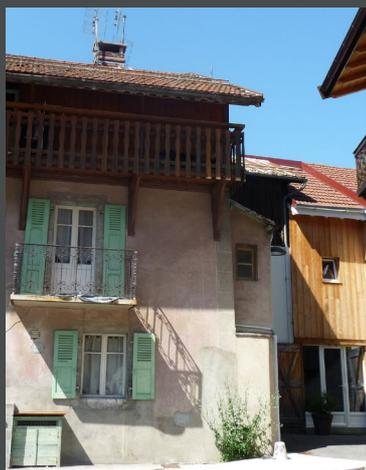
"Revêtement extérieur ou paroi sans ouvertures, sous le toit, fixé sur l'ossature, qui a pour fonctions l'esthétique et la protection du bâtiment", cet habillage, en bois le plus souvent, doit être choisi en accord avec les façades et les menuiseries, dont il peut être de même teinte, plus foncé ou équivalent à leur valeur (luminosité).
