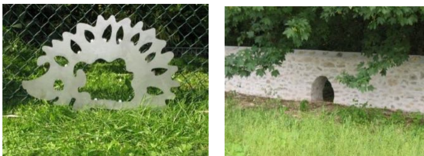
Exemples de passages troués dans les clôtures
