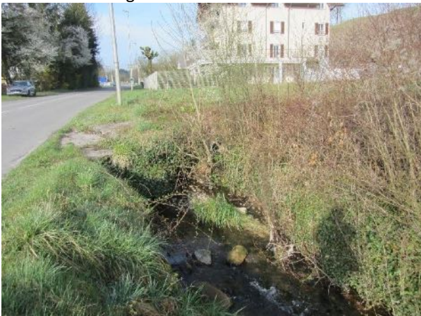
Photo 29 : Passage du ruisseau d'Hisson sous la RD907a
